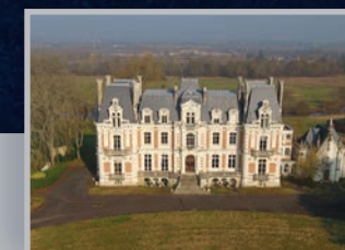
CHÂTEAU DU MARQUIS DE SAVONNIÈRES
